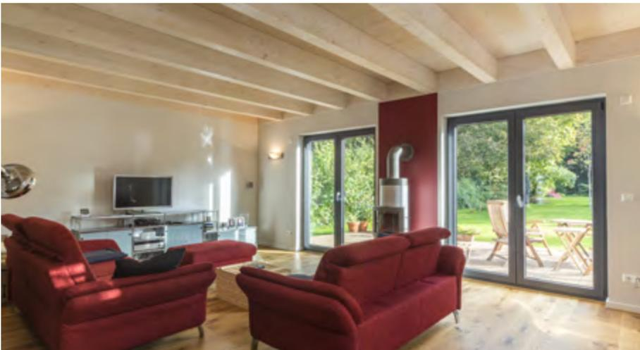
Variante 1: Sichtbare Leimholzdecke in natur (bei ausgebauten Obergeschossen), farbige Anstriche der Leimholzdecke sind Eigenleistung des Bauherren.
